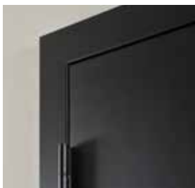
Omlijsting in verstek, deur en omlijsting in hetzelfde vlak
